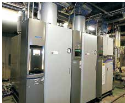
更新したボイラー
