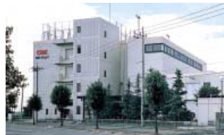
技術センター工場 群馬県伊勢崎市 研究・開発の中核拠点及び半導体パッケージ用サブストレートを製造しています。
